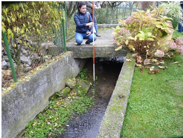
Fotografija 1-3: Vodotok Šemnica; propust 2 oko stac. km 2+851
