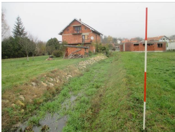
Fotografija 1-7: Šemnica, postojeće stanje; stara obaloutvrda na desnoj obali oko stac. km 2+747 (u tablici 1-1 Obaloutvrda 2)
