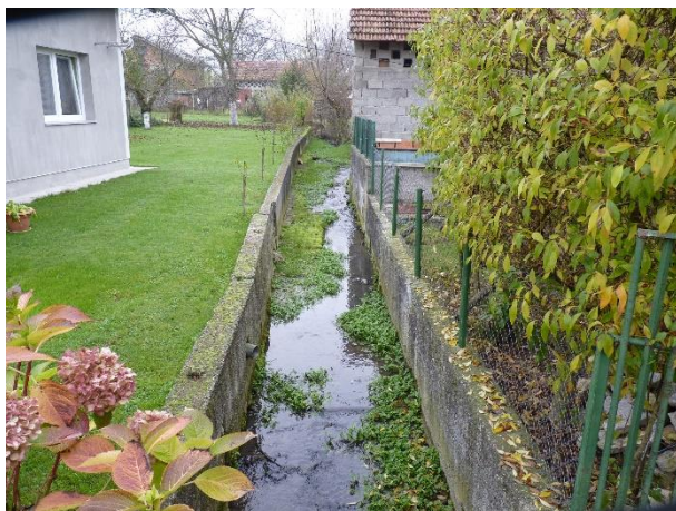
Fotografija 1-4: Vodotok Šemnica; betonirano korito na uzvodnom dijelu trase, u naseljenome području
