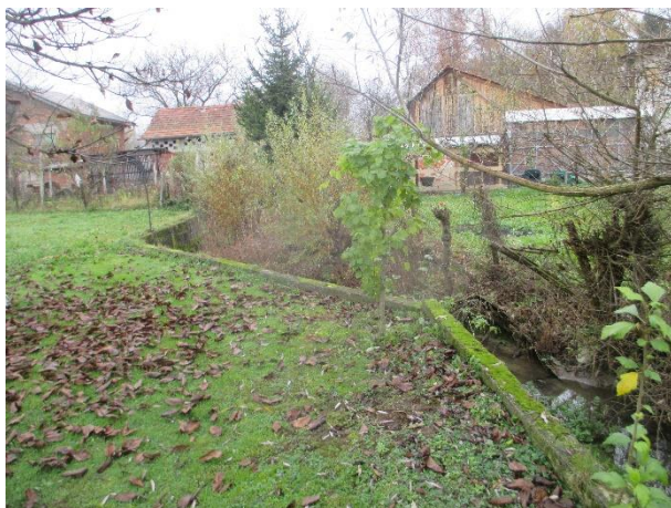
Fotografija 1-5: Vodotok Šemnica; betonirano korito na uzvodnom dijelu trase, u naseljenome području
