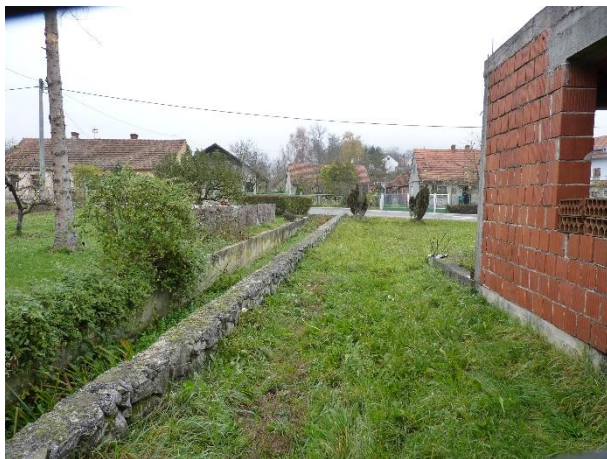
Fotografija 1-6: Vodotok Šemnica; betonirano korito u naseljenom dijelu, nizvodno od županijske ceste
