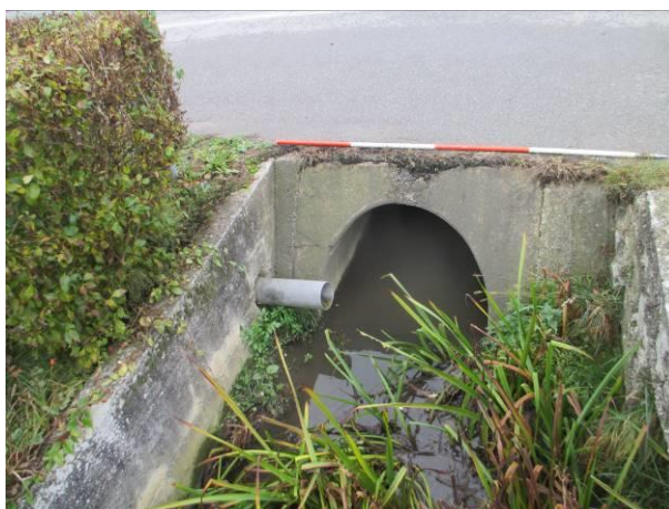
Fotografija 1-1: Postojeći propust ispod županijske ceste \phi 100; os ceste na stac. km 2+828 – nizvodno od ceste
