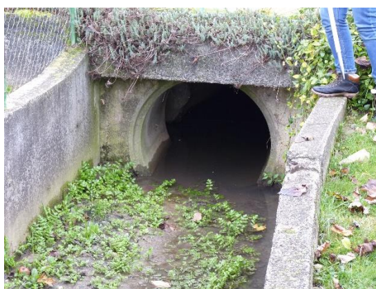
Fotografija 1-2: Postojeći propust ispod županijske ceste \phi 100; os ceste na stac. km 2+828 - uzvodno od ceste
