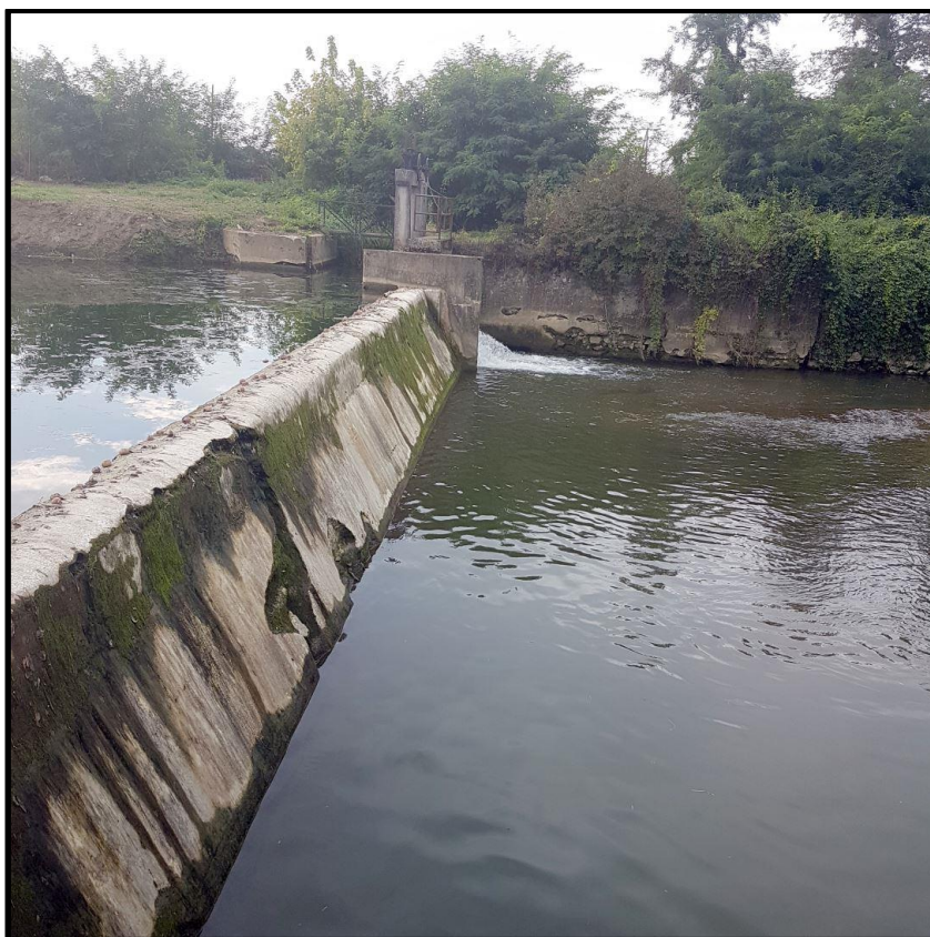
Slika 2.1-3. Postojeća betonska brana na potoku Topličina – kraj zahvata uređenja (potok Topličina u rkm 5+300)
