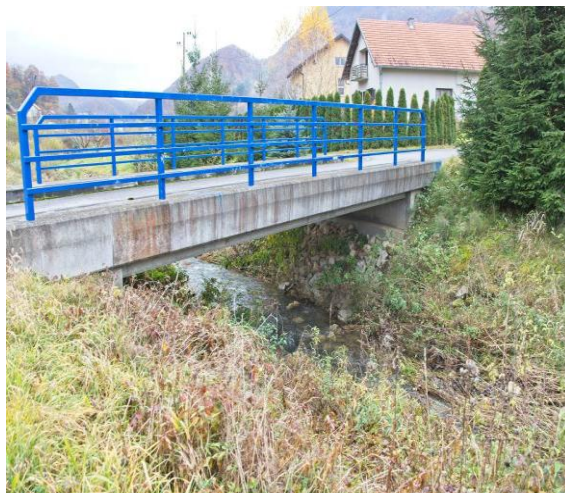
Slika 15. Most na stac 1+138
