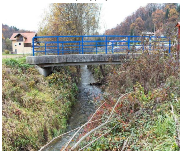
Slika 19. Most na stac 2+270
