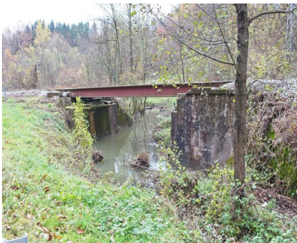
Slika 22. Željeznički most na stac 3+200
