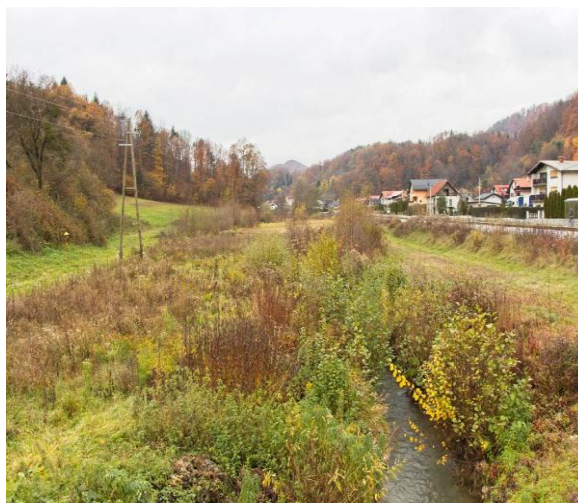
Slika 17. Most na stac 1+428 – pogled uzvodno
