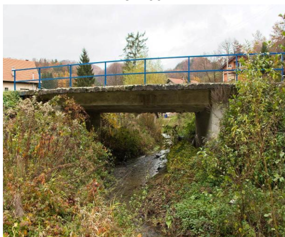
Slika 25. Most na stac 3+439
