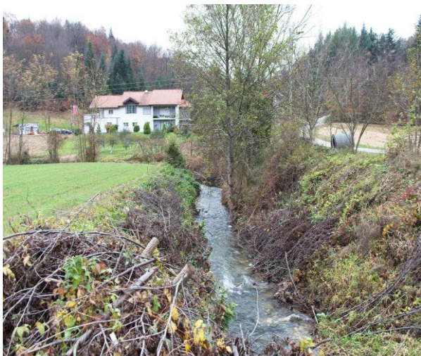
Slika 20. Most na stac 2+270 – pogled uzvodno
