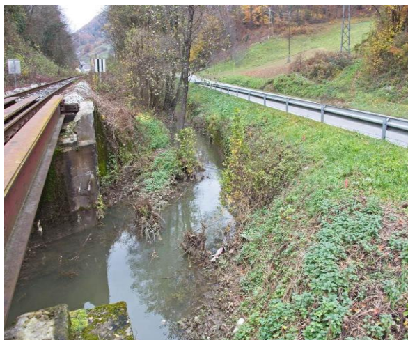
Slika 23. Željeznički most na stac 3+200
