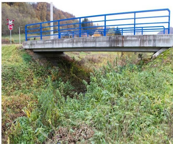
Slika 16. Most na stac 1+428
