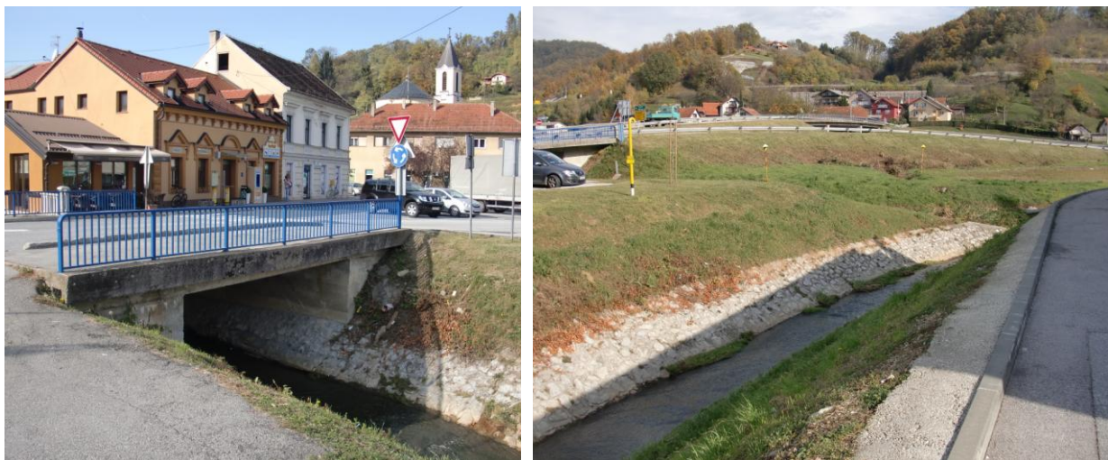
Slika 1. Uređeno korito potoka Putkovec u središtu naselja Đurmanec
