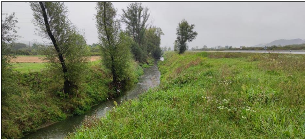
Slika 2 Pogled na dionicu potoka Krapinica od rkm 7+500 do rkm 8+000
