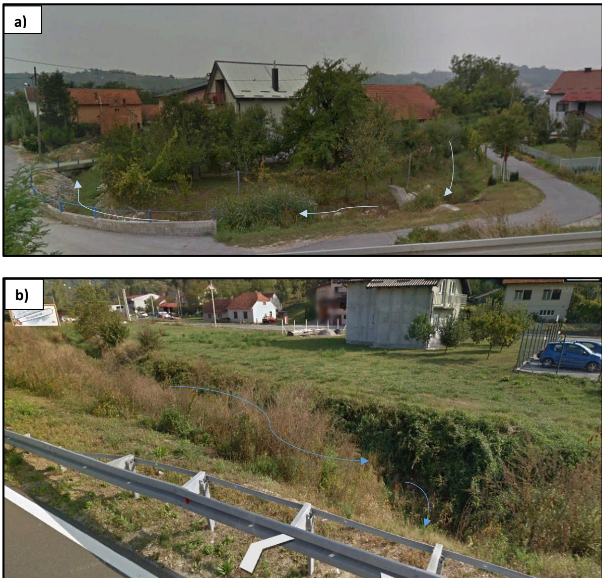
Slika 2.1-1. Pogled s državne ceste DC1 na potok Mihaljekov jarek s označenim smjerom tečenja: (a) južni dio predmetne dionice u predjelu Putine i (b) sjeverni dio predmetne dionice, na lokaciji križanja potoka s DC1 (izvor: Google Earth aplikacija, 2021.)
