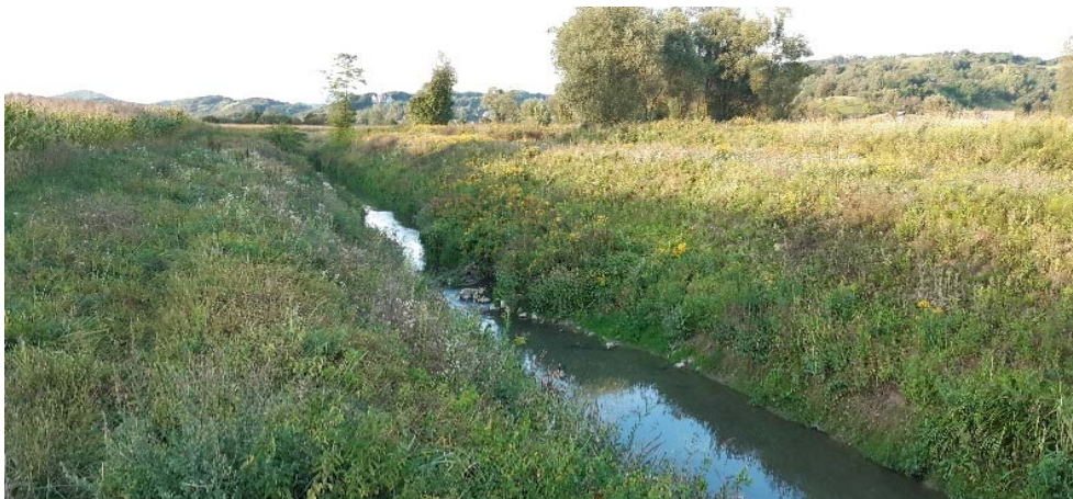
Fotografija 2-42: Odron, na lijevoj obali Kosteljine, nalazi se na stac. km \approx 2+665 (u Tablici 2-1 je opisan kao Odron 15)
