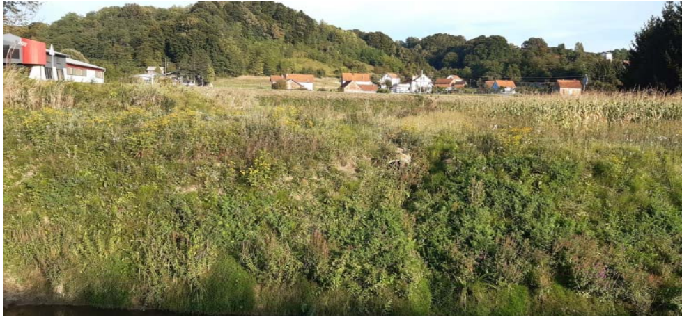
Fotografija 2-17: Propust na lijevoj obali Kosteljine, nalazi se na stac. km \approx 1+975 (u tablici 2-1 je opisan kao Propust 5)
