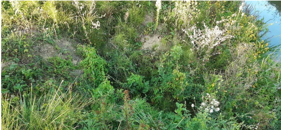
Fotografija 2-31: Propust, na desnoj obali Kosteljine, promjera cijevi 80 cm nalazi se na stac. km \approx 2+416 (u Tablici 2-1 je opisan kao Propust 11)
