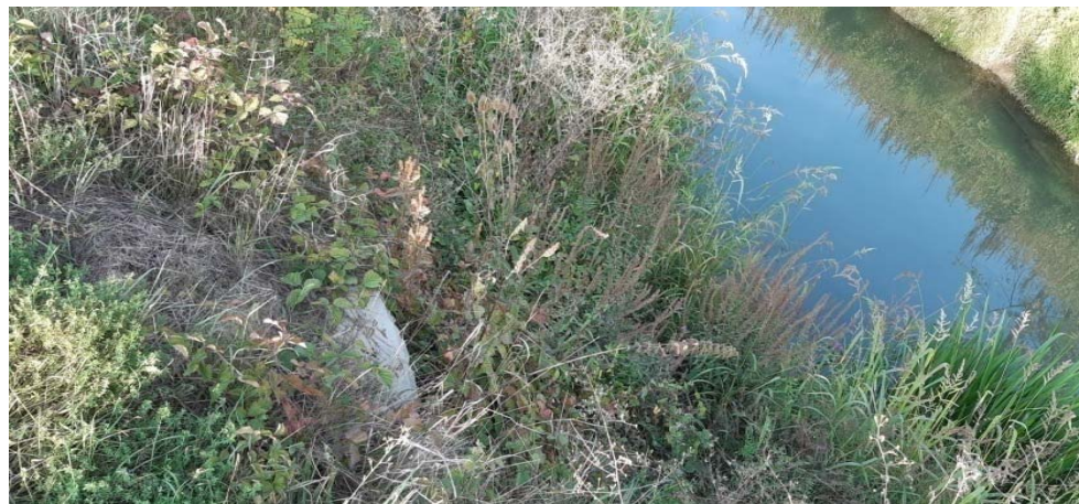
Fotografija 2-18: Propust, izrazito tankoga popucanoga nadsloja zemlje, betonska cijev promjera 80 cm na desnoj obali Kosteljine, nalazi se na stac. km \approx 1+998 (u Tablici 2-1 je opisan kao Propust 6)
