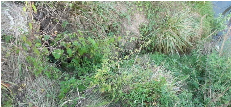
Fotografija 2-14: Propust na desnoj obali Kosteljine, promjer cijevi je 80 cm, nalazi se na stac. km \approx 1+911 (u Tablici 2-1 je opisan kao Propust 2)
