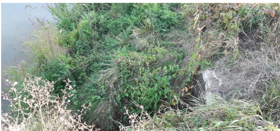
Fotografija 2-15: Propust, betonska cijev promjera 80 cm na desnoj obali Kosteljine sa zemljanim nadslojem, nalazi se na stac. km \approx 1+931 (u Tablici 2-1 je opisan kao Propust 3)
