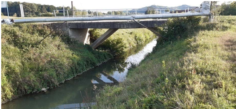
Fotografija 2-6: Kosteljina; prikaz mosta (stac. km \approx 1+797 ) i obaloutvrde (stac. km \approx 1+804 ) na lijevoj obali Kosteljine, pogled prema nizvodno (u Tablici 2-1 Most 1 i Obaloutvrda 2)
