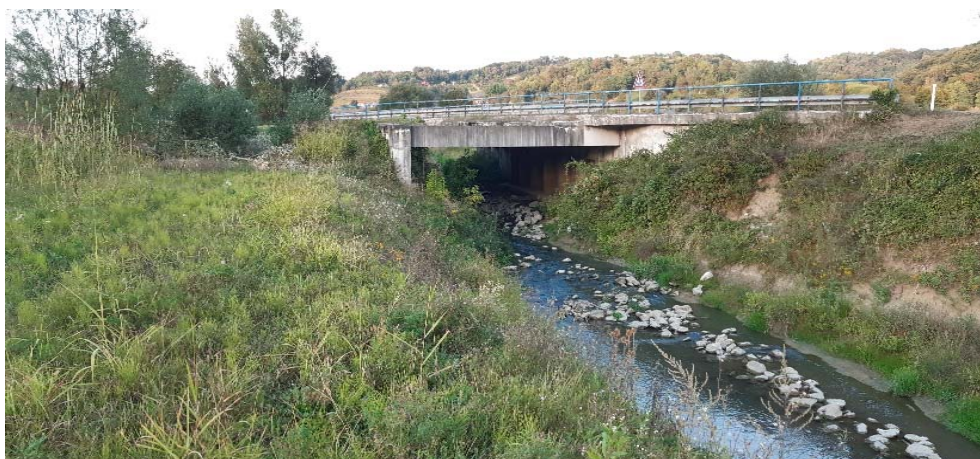
Fotografija 2-51: Odron, na desnoj obali Kosteljine, nalazi se na stac. km \approx 2+980 (u Tablici 2-1 je opisan kao Odron 20, na fotografiji vidljivi Most 2)
