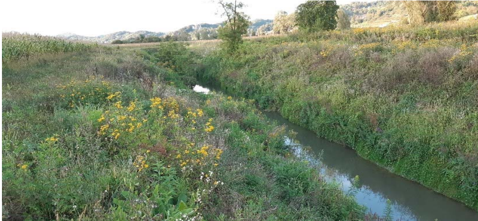
Fotografija 2-45: Odron, na desnoj obali Kosteljine, nalazi se na stac. km \approx 2+729 (u Tablici 2-1 je opisan kao Odron 17)
