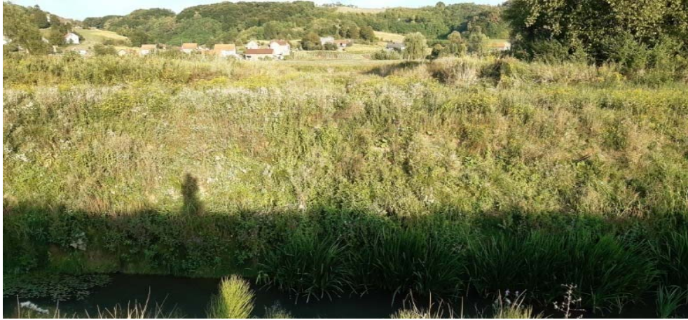
Fotografija 2-27: Propust, na lijevoj obali Kosteljine, promjera cijevi 100 cm, teže se nazire uslijed obraslosti travom, nalazi se na stac. km \approx 2+340 (u Tablici 2-1 je opisan kao Propust 8)
