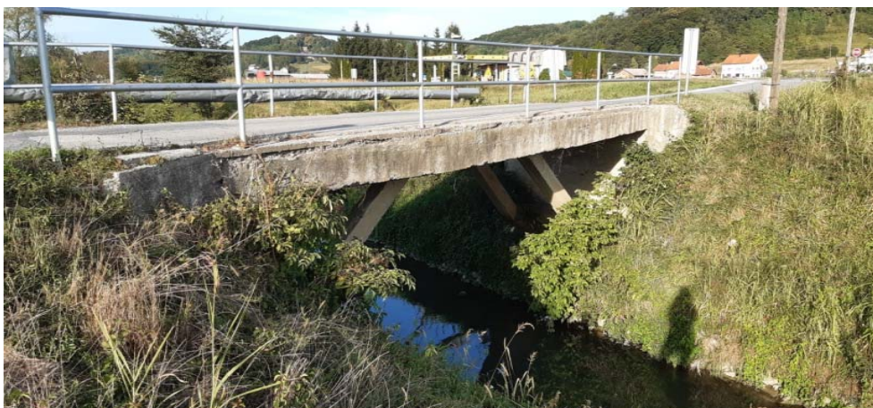
Fotografija 2-5: Kosteljina; prikaz mosta na nizvodnome dijelu dionice obuhvata zahvata na stac. km \approx 1+797 , pogled prema uzvodno (u Tablici 2-1 Most 1)
