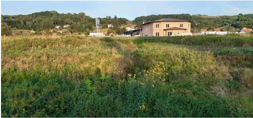
Fotografija 2-39: Propust, na lijevoj obali Kosteljine, nalazi se na stac. km \approx 2+600 (u Tablici 2-1 je opisan kao Propust 15)
