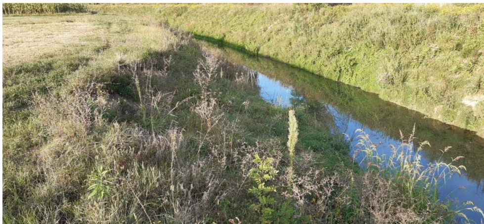
Fotografija 2-19: Odron na desnoj obali Kosteljine, dublje klizne plohe, nalazi se na stac. km \approx 2+005 (u Tablici 2-1 je opisan kao Odron 5 i duljine je oko 6 m)
