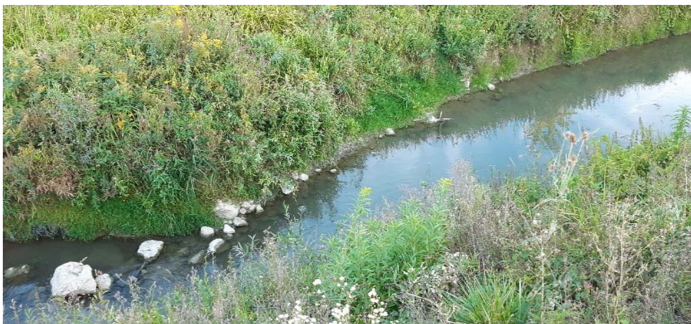
Fotografija 2-40 i 2-41: Obaloutvrda, na lijevoj obali Kosteljine, uz Odron 15, nalazi se na stac. km \approx 2+655 (u Tablici 2-1 je opisana kao Obaloutvrda 6)
