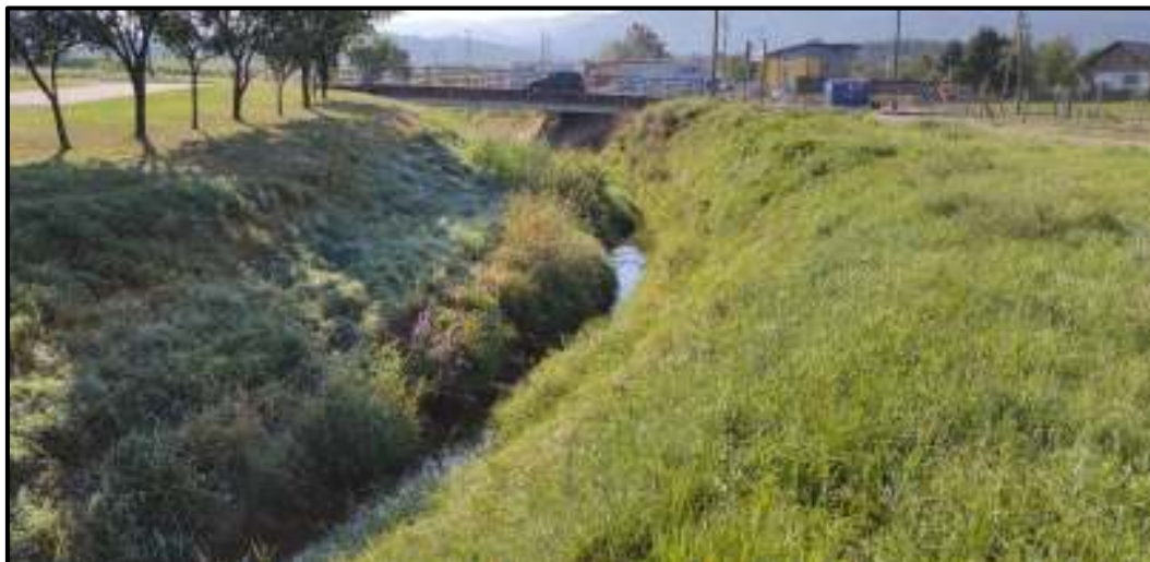
Slika 2.1-5. Karakteristični izgled postojećeg korita potoka Topličina: smanjenje proticajnog profila uslijed taloženja materijala u koritu (izvor: Viacon, 2022.)
