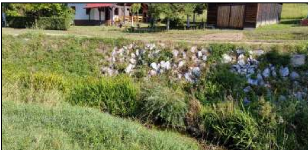
Slika 2.1-7. Karakteristični izgled postojećeg korita potoka Topličina: djelomično izvedena zaštita pokosa lomljenim kamenom (izvor: Viacon, 2022.)
