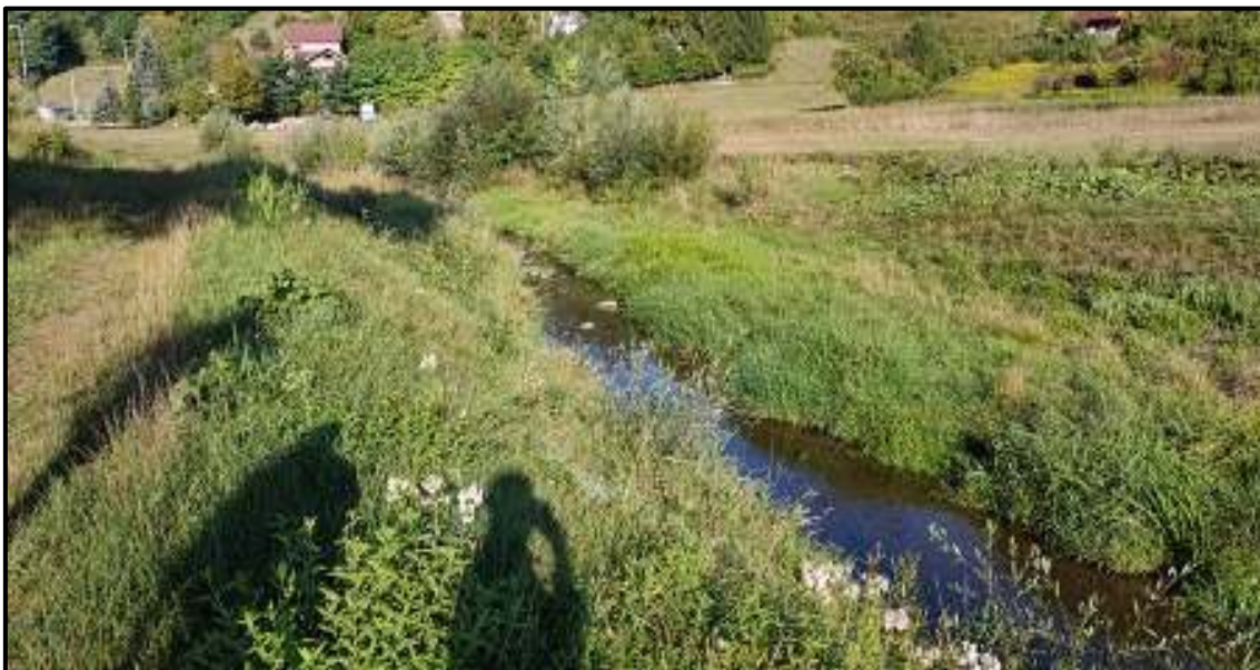
Slika 2.1-1. Početak predmetne dionice potoka Topličina (izvor: Viacon, 2022. )
