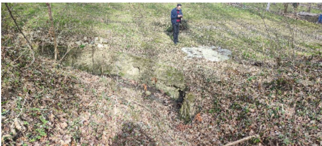
Slika 2-5. Pogled na postojeću ulaznu građevinu
