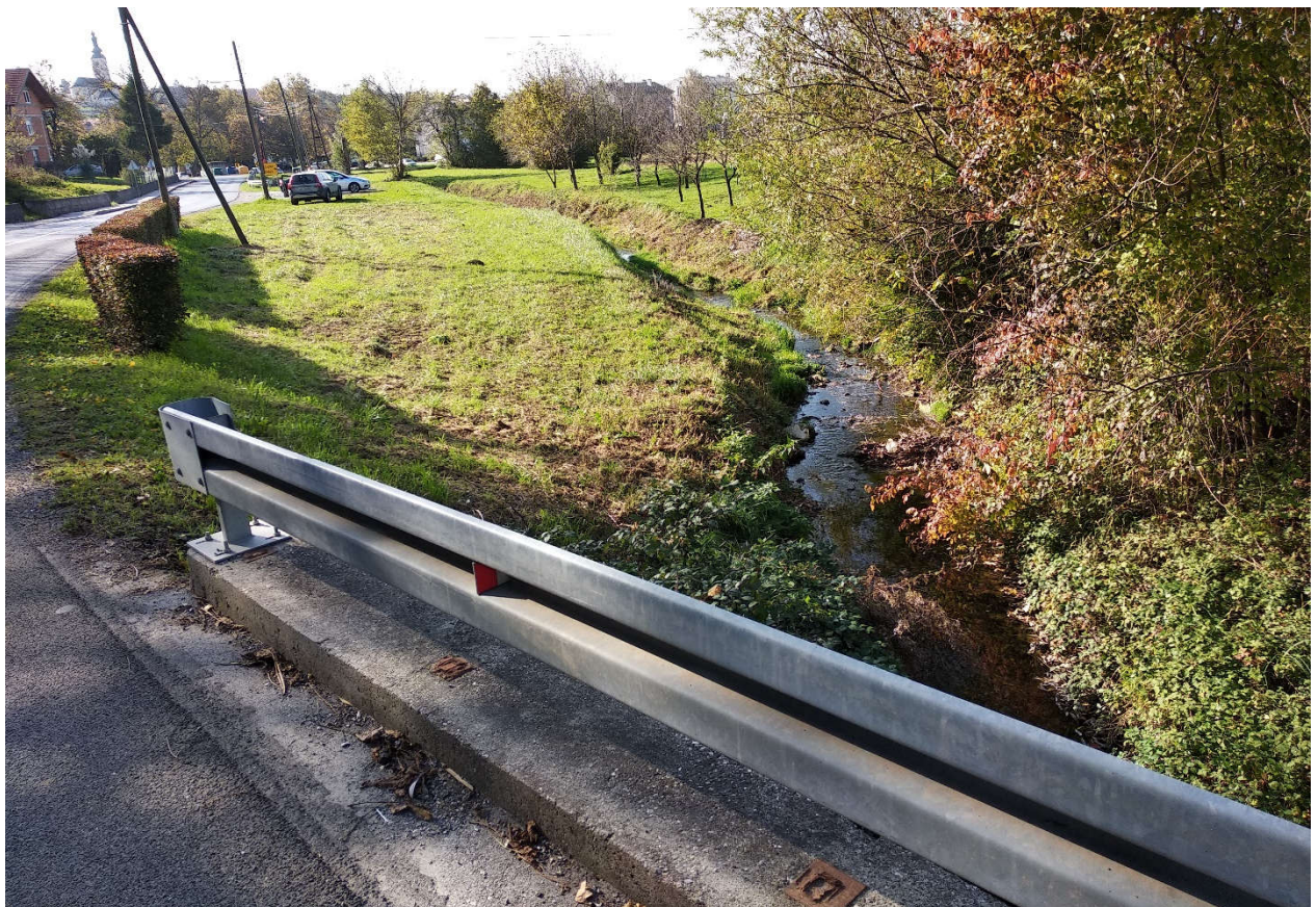
Slika 3. Pogled na lokaciju zahvata nizvodno od završne stacionaže
