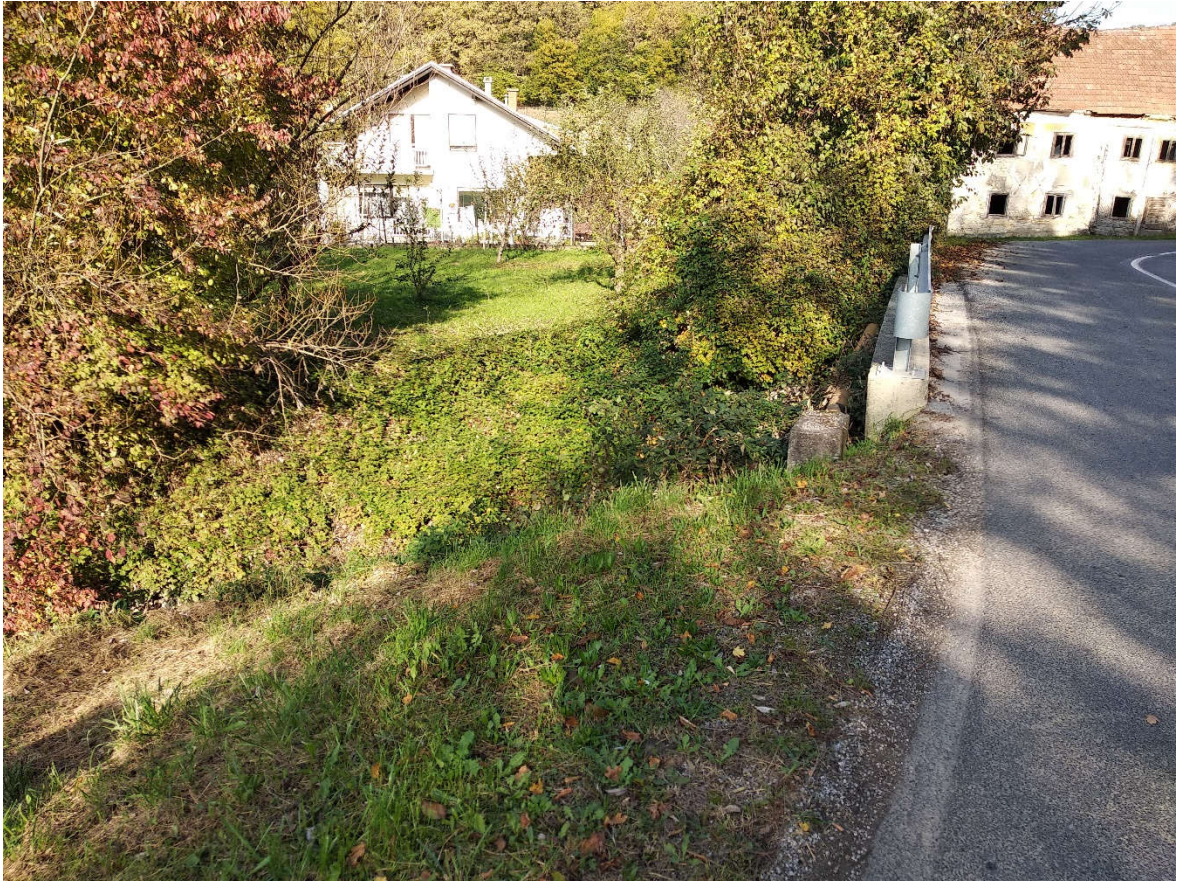
Slika 2. Pogled na stacionažu 1+095 i kraj predmetnog zahvata
