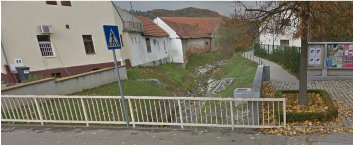
Slika 4.1.3.-2. Potok Rijeka uzvodno od cestovnog mosta u Donjoj Stubici
