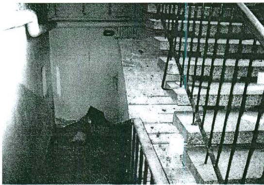
krilo ambulante - stubište
