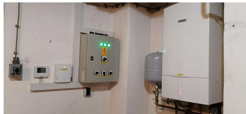
Sanacija kotlovnice Ispostava Zabok
