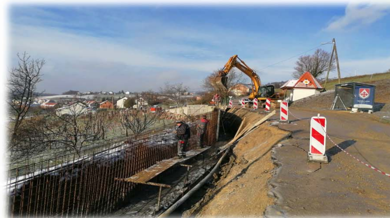
Slika 2. Sanacija klizišta Vojnovec Loborski
