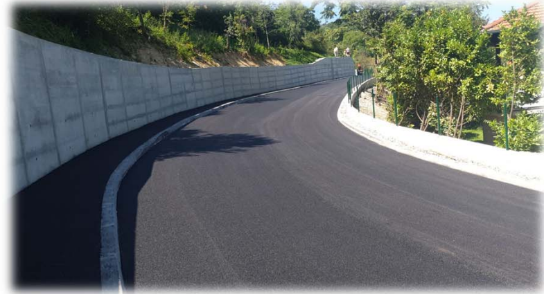
Slika 6. Sanacija klizišta Tuheljske Toplice
