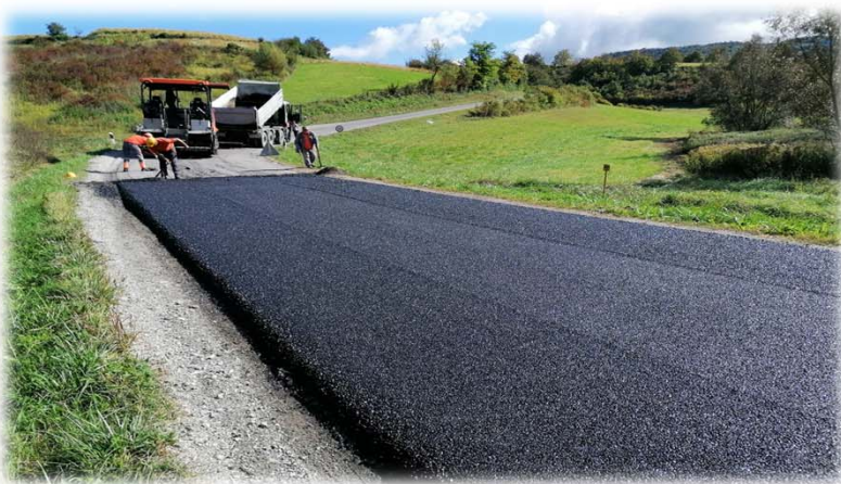
Slika 3. Ugradnja BBTM asfalta Sveti Matej
