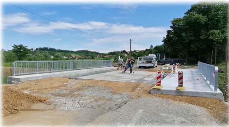
Slika 7. Sanacija mosta Samci
