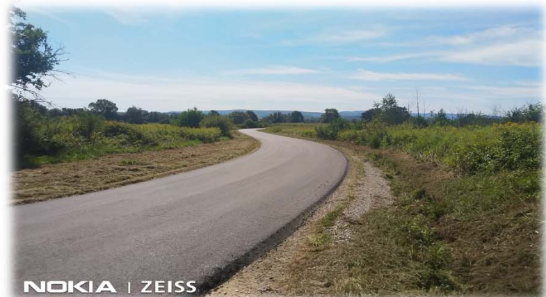
Slika 8. Sanacija kolničkog zastora G. Konjščina
