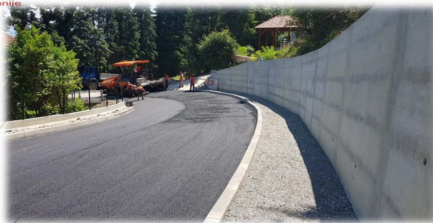
Slika; Sanacija klizišta – Tuheljske Toplice
