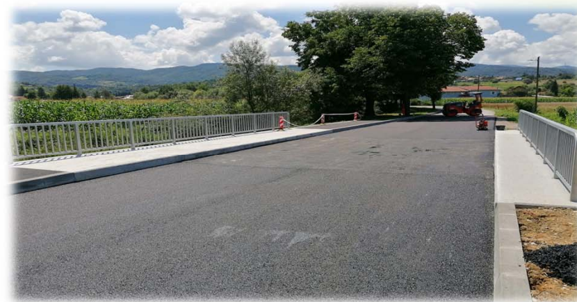
Slika; Sanacija mosta – Gornja Stubica
