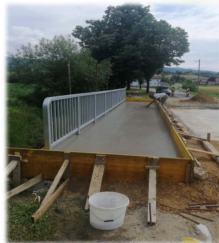
Slika; Sanacija mosta u Gornjoj Stubici
