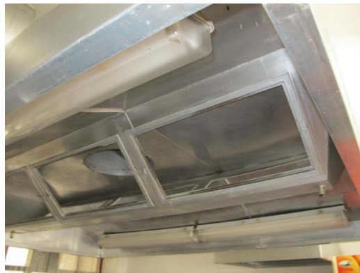
Slika 1.10. Prikaz sustava prisilne ventilacije kuhinje (napa)
