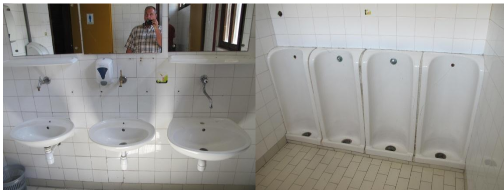
Slika 1.35 Izljevni mjesta sanitarne vode
