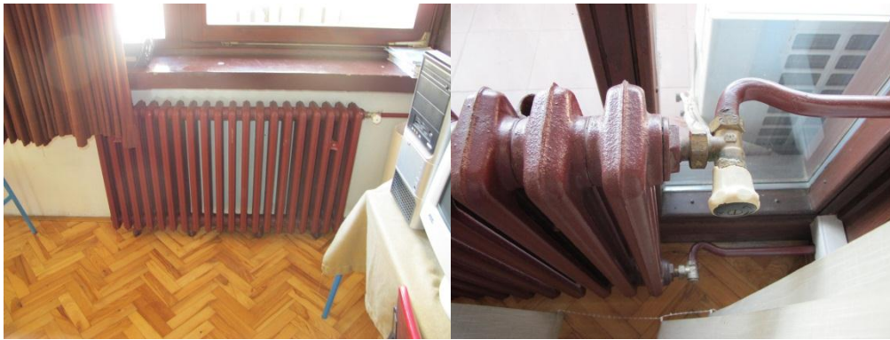
Slika 1.8 Prikaz ogrjevnih tijela sustava grijanja Izvor: REGEA
