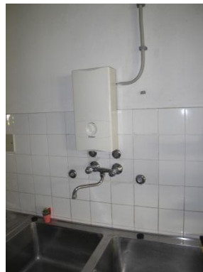
Slika 1.30 Prikaz električnog bojlera
