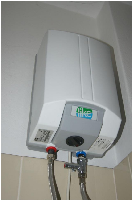
Slika 1.21 Električni bojler
