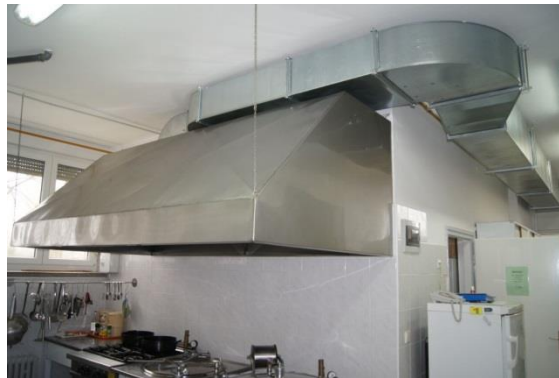
Slika 1.6. Prikaz sustava prisilne ventilacije kuhinje (napa)
