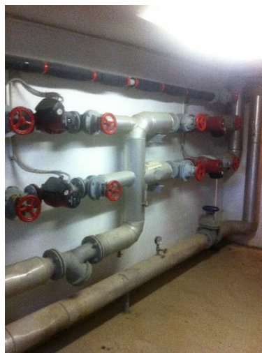
Slika 1.5 Prikaz razvoda sustava grijanja u toplinskoj podstanci
