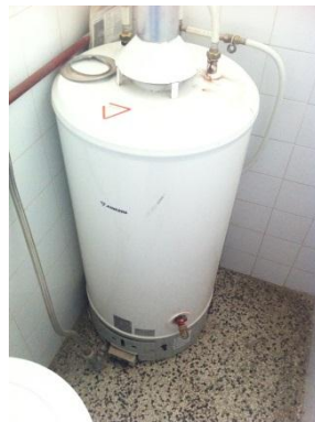
Slika 1.8 Prikaz bojlera na prirodni plin
