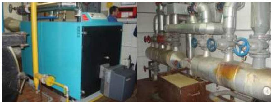
Slika 1.5 Prikaz kotla i razvoda sustava grijanja
