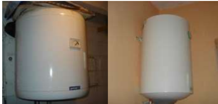
Slika 1.8 Prikaz električnih akumulacijskih bojlera
