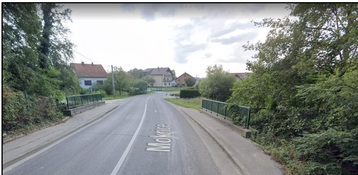
Slika 2.1-2. Propust potoka Jarek na državnoj cesti DC307 (izvor: Google Maps, 2023.)
