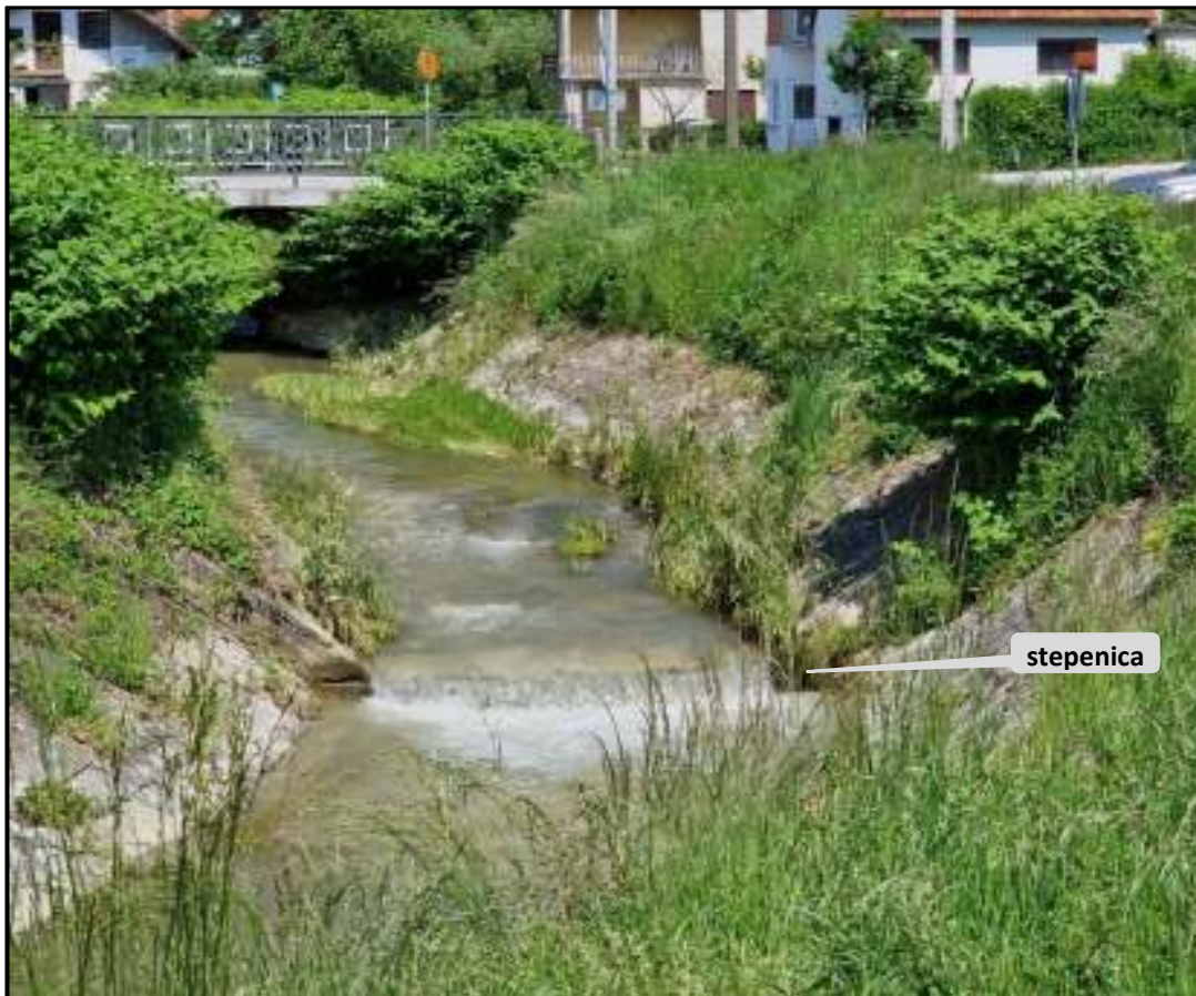
Slika 4.4.2-1. Postojeća hidrotehnička stepenica na lokaciji oko 600 m uzvodno od obuhvata zahvata (snimljeno 21.05.2023.)
