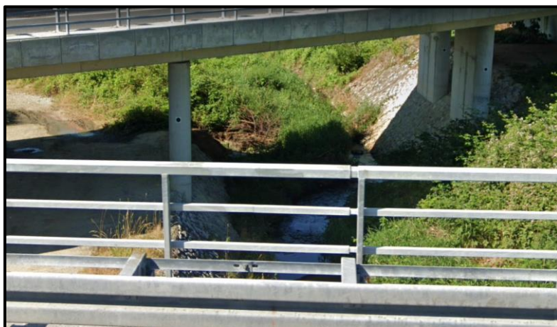
Slika 2.1-2. Pogled s AC2 na potok Radobojčicu (izvor: Google Earth, 2023.)
