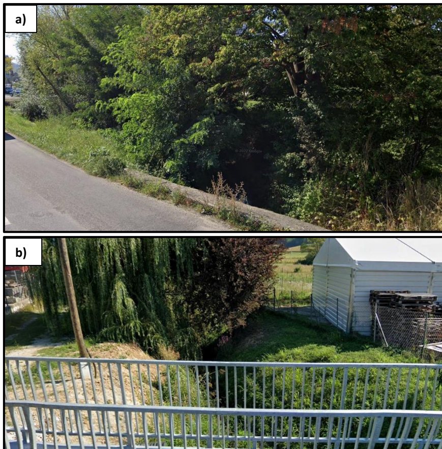
Slika 2.1-1. Pogled s nerazvrstane ceste V. Ves na potok Radobojčicu, oko stac. km 0+592,29: (a) nizvodno, i (b) uzvodno (izvor: Google Maps, 2023.)
