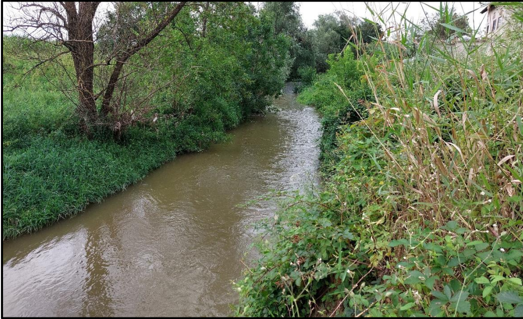
Slika 2.1-5. Korito uzvodno od stac. km 0+975,00 (snimljeno 23.07.2023.)
