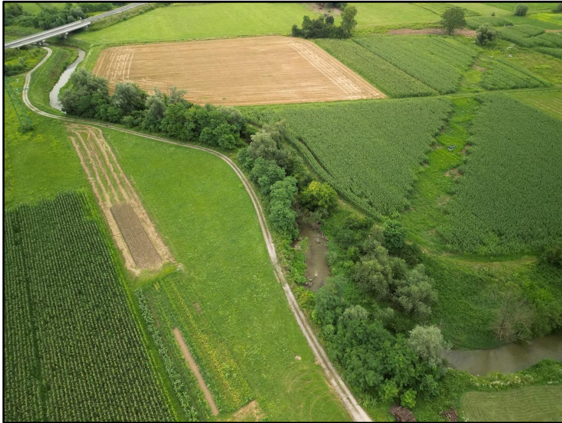
Slika 2.1-2. Korito potoka Topličina uzvodno od DC14, od stac. km 0+630,00 do km 0+990,00 (snimljeno 23.07.2023.)
