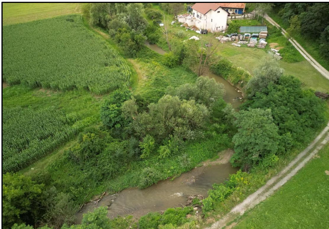
Slika 2.1-3. Oštećena lijeva obala potoka Topličina i ugroženi poljski put na stac. km 0+935,00; pogled uzvodno prema stambenom i gospodarskom objektu (snimljeno 23.07.2023.)
