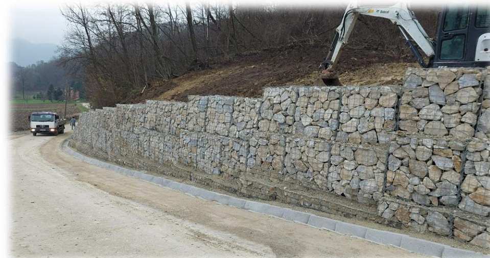
Slika: Sanacija klizišta Donji Škrnik na L22027
