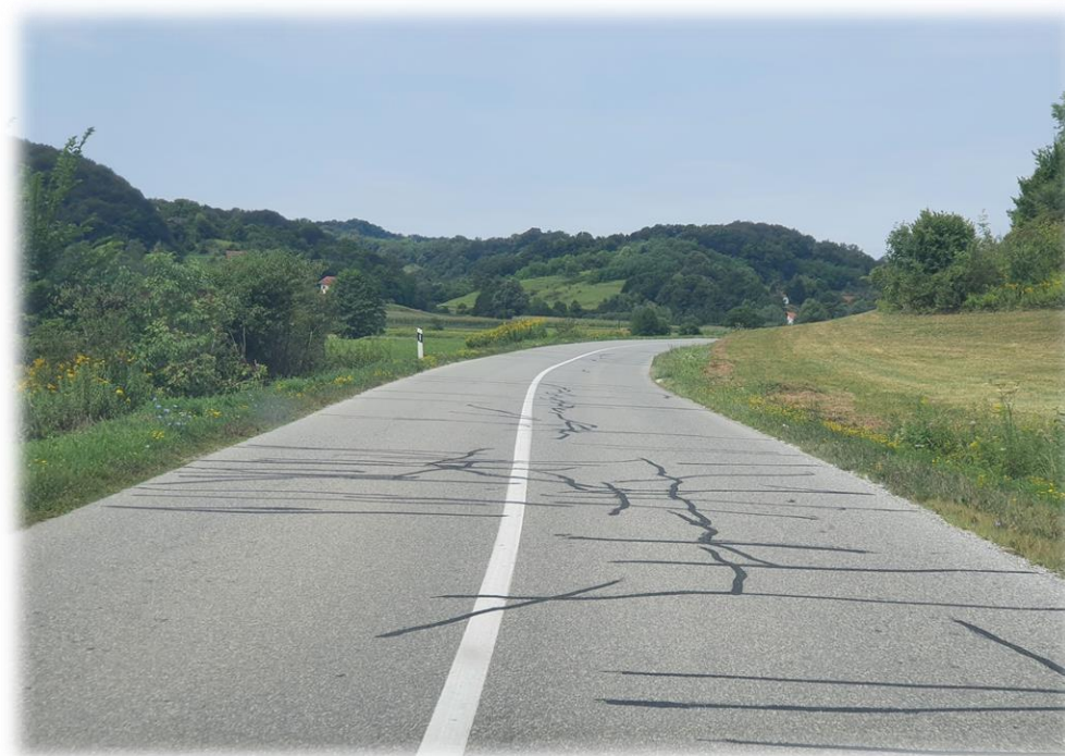
Slika: Sanacija pukotina na Ž2248 i Ž2219
