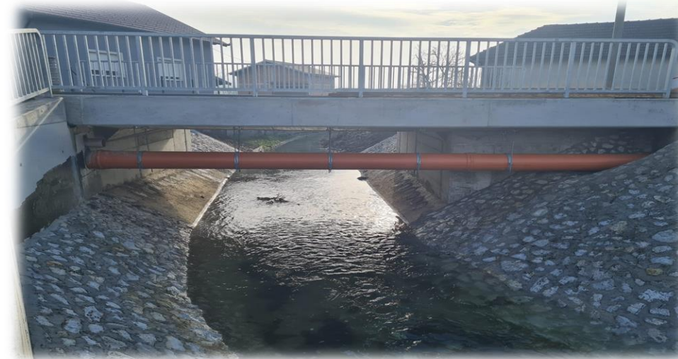
Slika: Sanacija propusta na L22025, Zlatar
