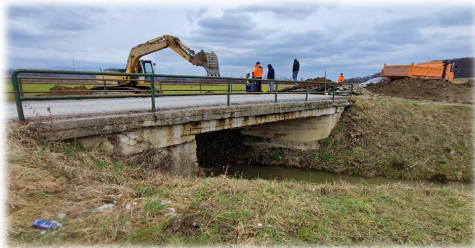
Slika: Sanacija propusta na L22087, Selnica
