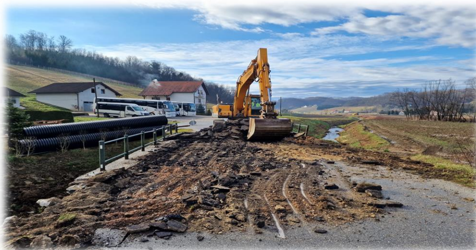
Slika: Sanacija propusta na Ž2248, Šimunci
