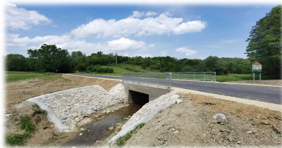
Slika: Sanacija propusta na L22066, Donji Sušobreg
