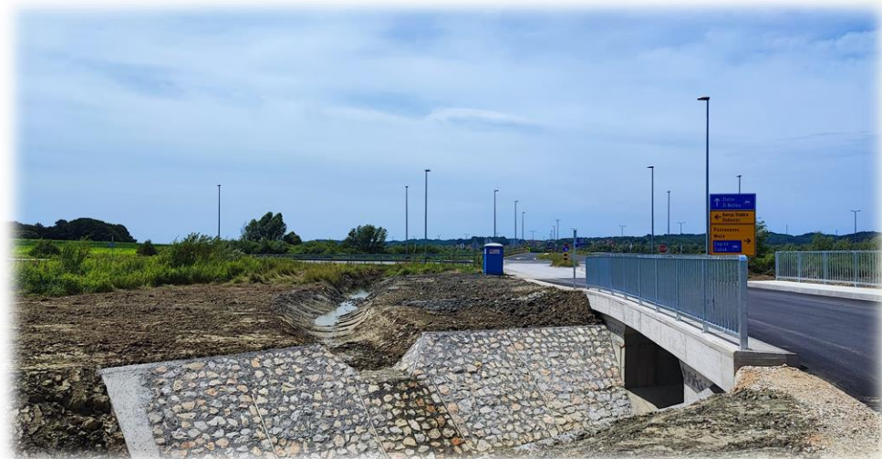
Slika: Sanacija propusta na L22087, Selnica
