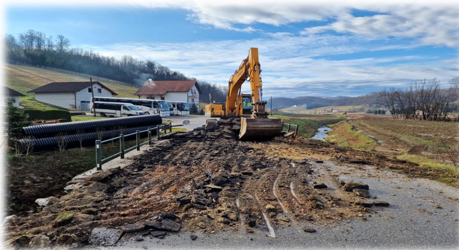
Slika: Sanacija propusta na ŽC2248, Šimunci
