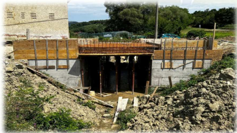
Slike: Rekonstrukcija propusta na LC22018, Repno
