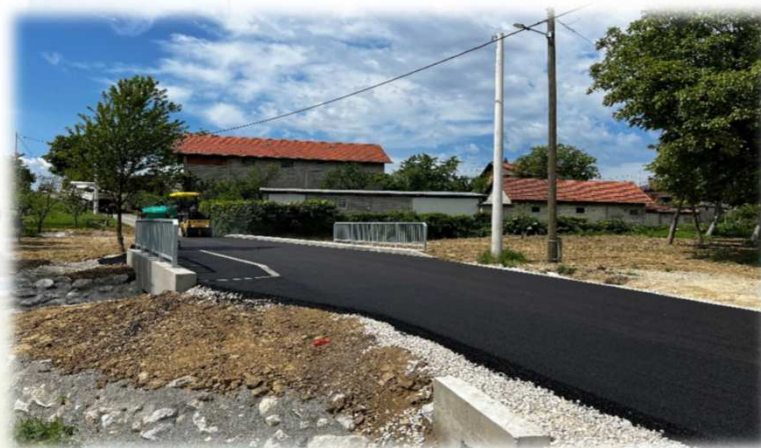
Slike: Rekonstrukcija propusta na LC22018, Repno
