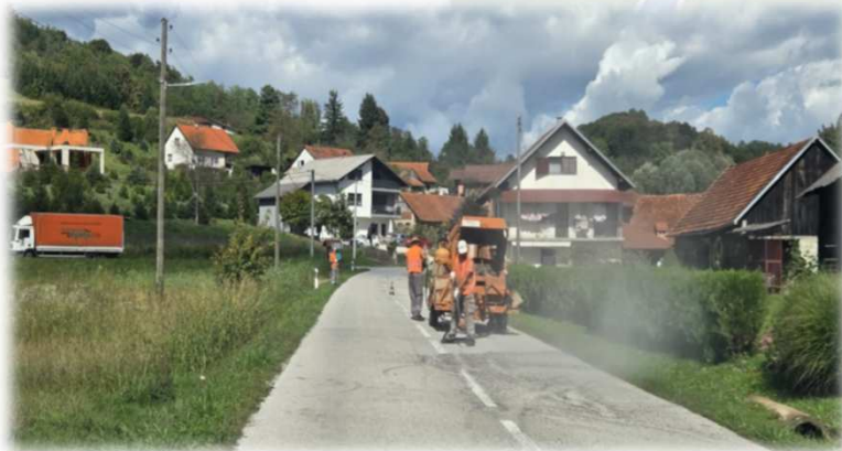
Slike: Sanacija pukotina u asfaltnom kolniku i ugradnja Tyregrip podloge
