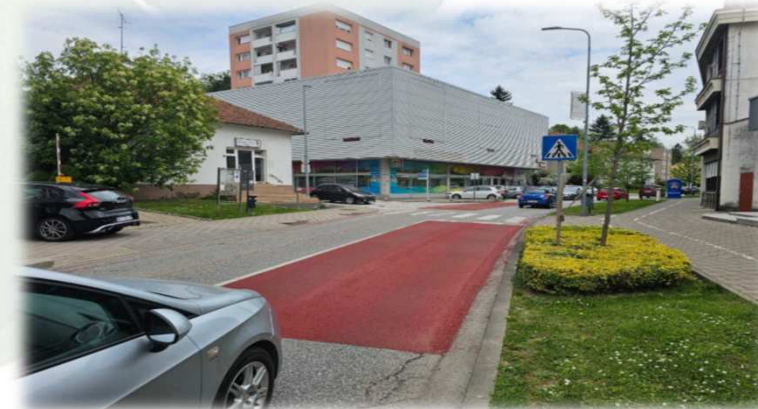
Slike: Sanacija pukotina u asfaltnom kolniku i ugradnja Tyregrip podloge
