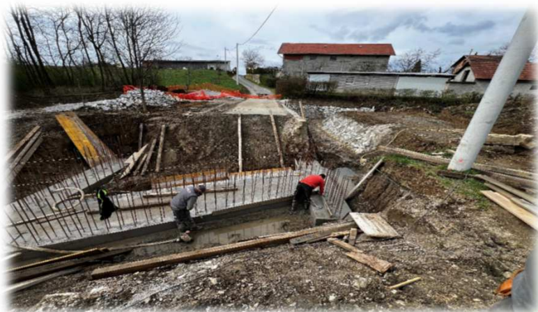
Slike: Rekonstrukcija propusta na LC22018, Repno
