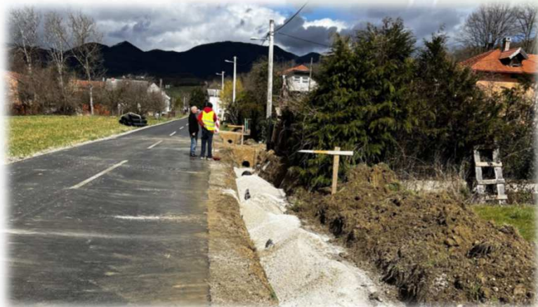
Slike: Uređenje oborinske odvodnje i pješačke staze na ŽC2128, Lobar
