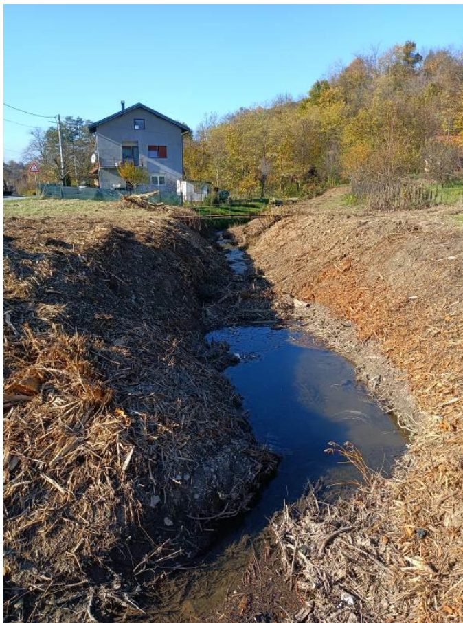
Slika 2-2. Pogled na početak trase potoka
