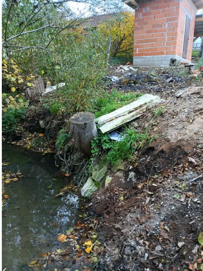
Slika 2-5. Obala potoka neposredno uzvodno od propusta
