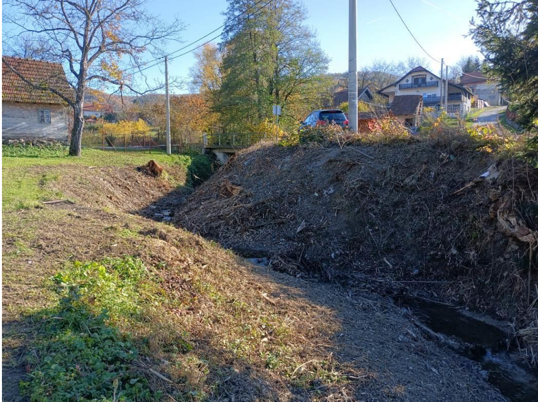
Slika 2-3. Pogled prema propustu s nizvodne strane
