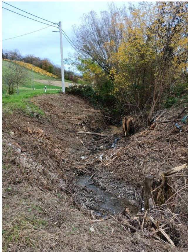
Slika 2-6. Korito potoka uzvodno od propusta
