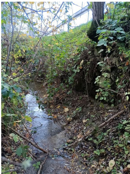
Slika 2-7. Erozijska na stac.3+580,00
