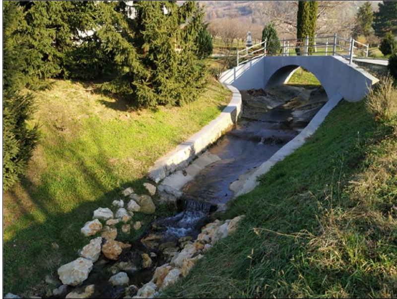
Slika 2-3. Most na ŽC 2122 Krapina-Radoboj, stac. 0+050,00 rkm
