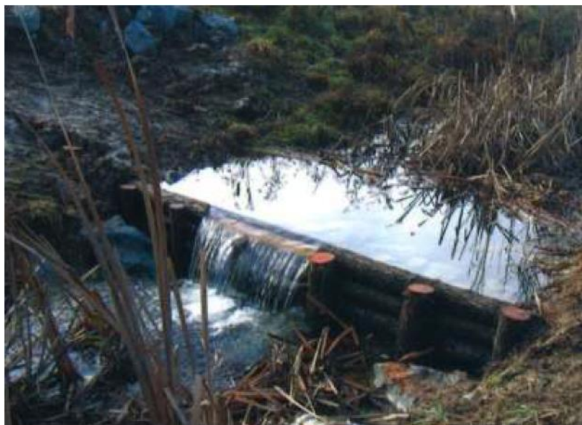
Slika 2-11. Poprečni profil drvenog praga u vodotoku
