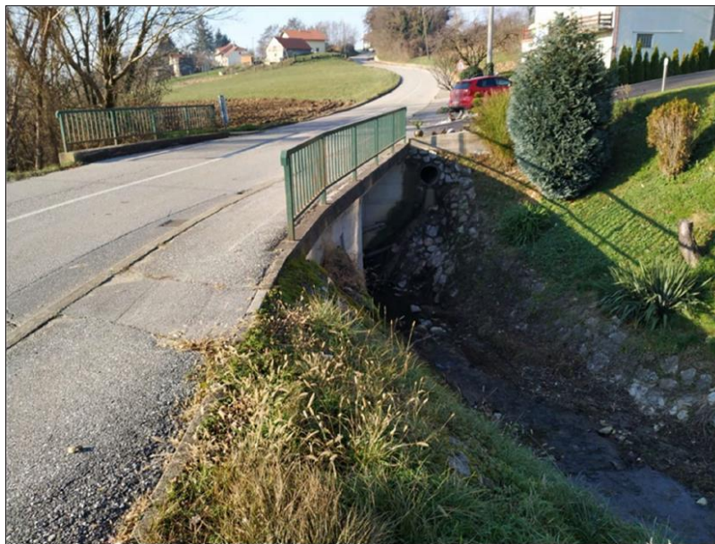
Slika 2-2. Most na ŽC 2122 Krapina-Radoboj, stac. 0+050,00 rkm
