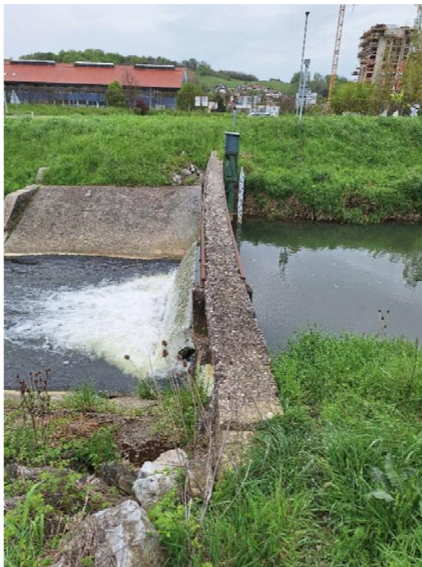
Sl. 2.2-5: Izgled armiranobetonskog preljeva i limnigrafske stanice u stac. 1+851,70
