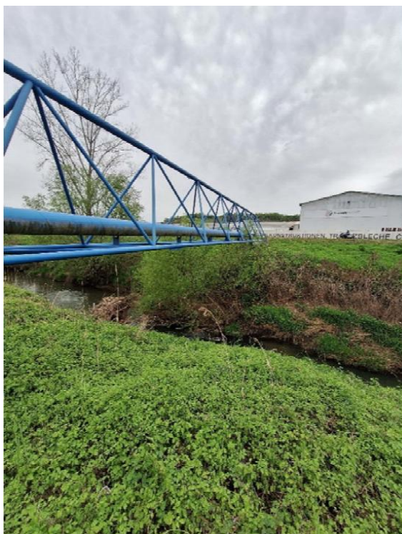
Sl. 2.2-7: Karakterističan izgled desne strane pokosa korita i most za vodovod na dionici zahvata 1+521,26 ostaci prijašnjih betonskih okna
