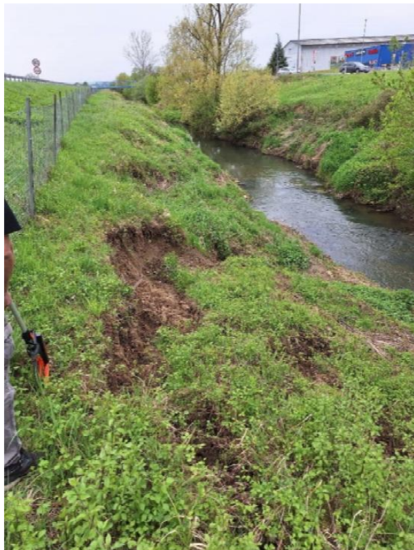
Sl. 2.2-6: Karakterističan izgled lijeve strane pokosa korita, formiranje klizišta nakon erodiranja materijala, stabla unutar slobodnog profila korita potoka na stac. 1+600,00
