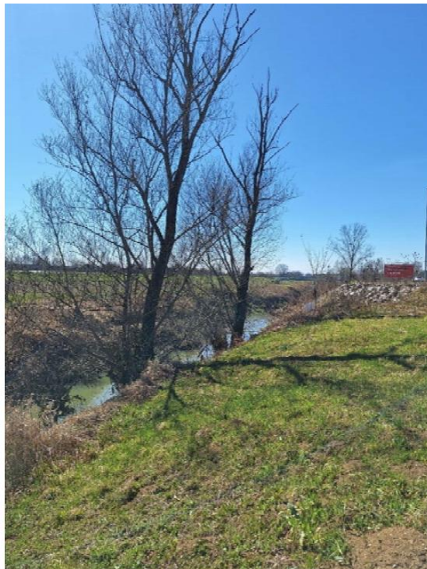
Sl. 2.2-6: Karakterističan izgled lijeve strane pokosa korita, formiranje klizišta nakon erodiranja materijala, stabla unutar slobodnog profila korita potoka na stac. 1+600,00
